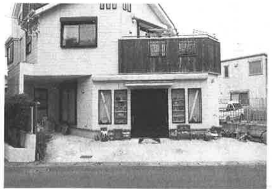
敷地形状を建築計画でカバーした店舗併用住宅
