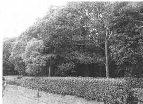
浦安市の幹線道路沿いに設けられた遮音のための植樹による環境施設帯
