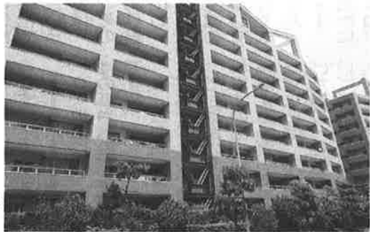
制震構造のM字型鉄骨が縦に連なる建物
