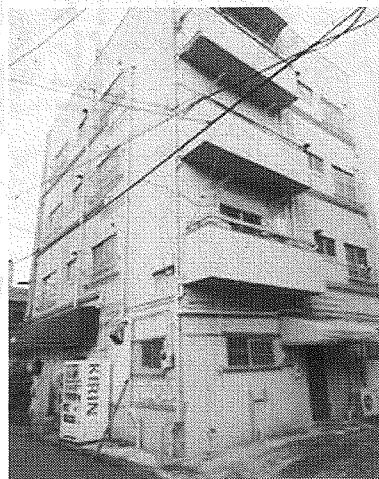
街には配管が露出した建物も目立つ
