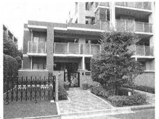
1階住戸に設けられた専用のアプローチと庭
