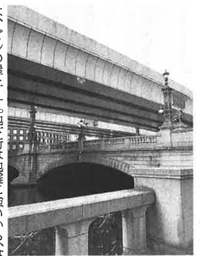
首都高が上を走る街道の起点・日本橋
