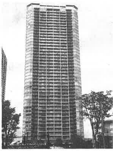
人気のタワーマンションは住みやすいのか (東京・豊洲で)
