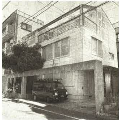
塀の役割を果たす鉄筋コンクリート造のゲート
