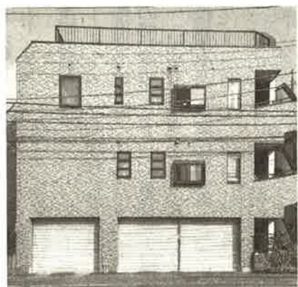
素朴な外観だが、各所に配慮も
