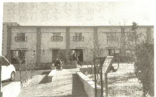
テラスハウスを改修した「ひばりテラス118」
