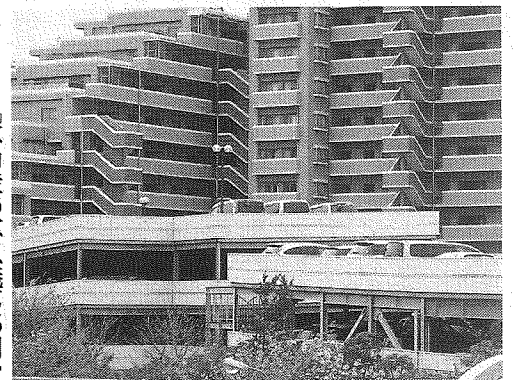
建物との一体感がない印象を受ける駐車場
